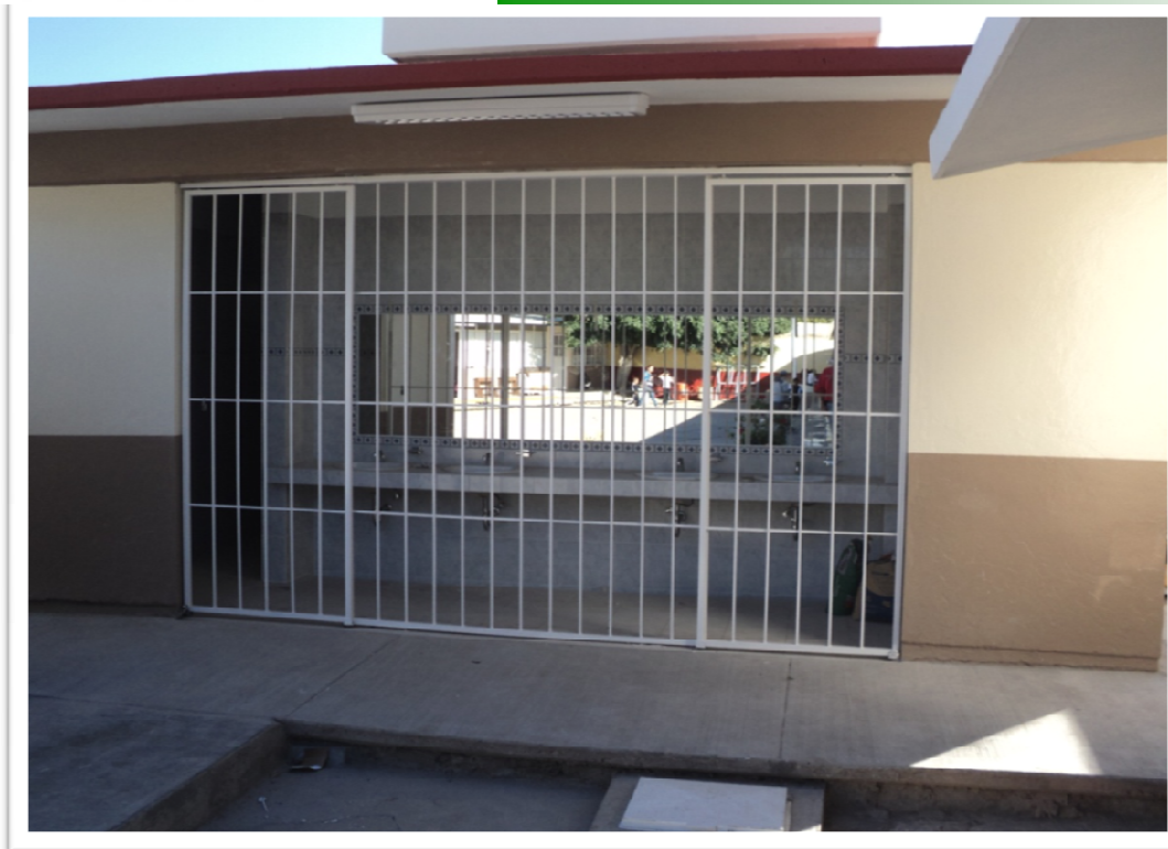
ESCUELA PRIMARIA "JOSE CIRIACO CRUZ" COLONIA SANTA FÉ SAN LUIS POTOSI, S.L.P. REHABILITACION GENERAL DE LA INFRAESTRUCTURA
