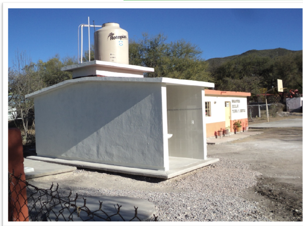
ESCUELA TELESECUNDARIA "EMILIANO ZAPATA" MORENOS SAN NICOLAS TOLENTINO, S.L.P. CONSTRUCCION DE SERVICIO SANITARIO TIPO RURAL Y OBRAS EXTERIORES
