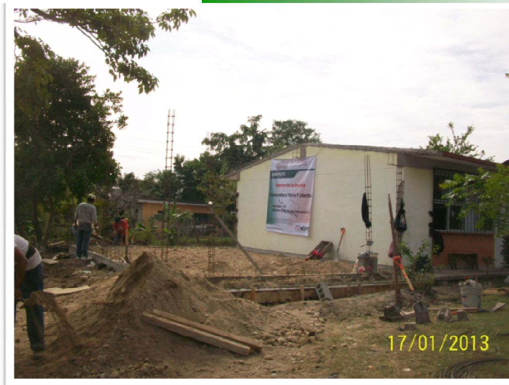
ESCUELA TELESECUNDARIA "TIERRA Y LIBERTAD" EJ. EL CIRUELAR SAN VICENTE TANCUAYALAB, S.L.P. CONSTRUCCION DE 1 AULA ESTR. REGIONAL 6X8 ADOSADA Y OB. EXT.
