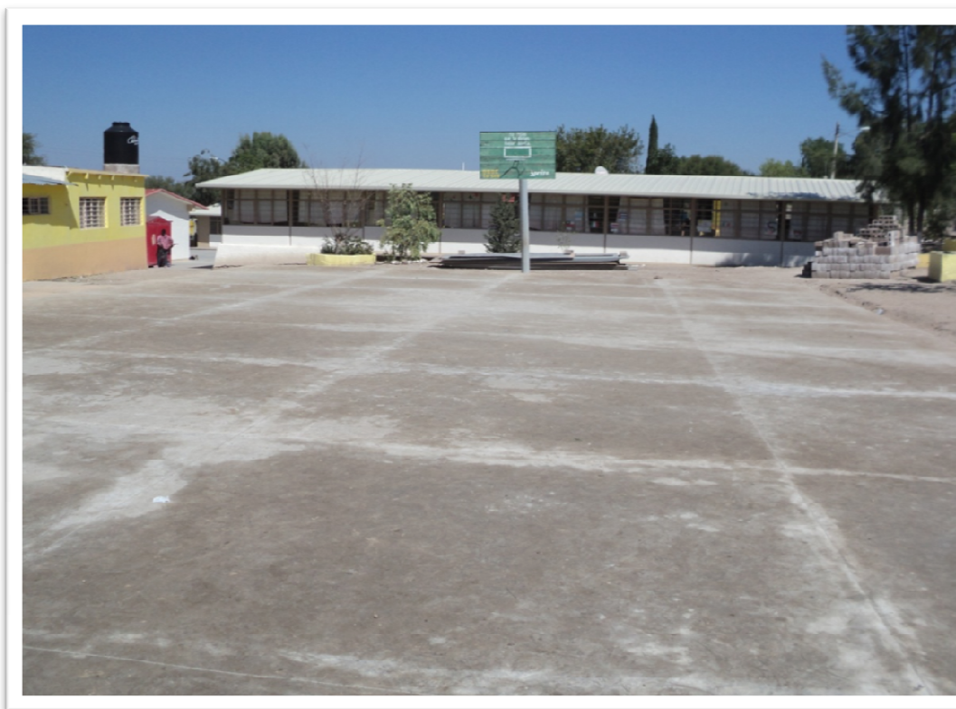
ESCUELA PRIMARIA "20 DE NOVIEMBRE" CERRITOS DE ZAVALA SAN LUIS POTOSI, S.L.P. REHABILITACION GENERAL DE LA INFRAESTRUCTURA
