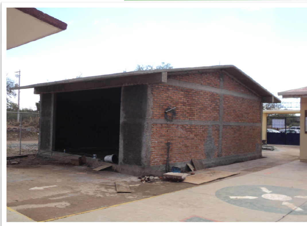
JARDIN DE NIÑOS "BLAS ESCONTRIA" PLANTA DEL CARMEN (EL OCHO) CERRO DE SAN PEDRO, S.L.P. CONSTRUCCION DE UN AULA DIDACTICA ESTRUCTURA REGIONAL 6.00 X 8.00 M. Y OBRAS EXTERIORES
